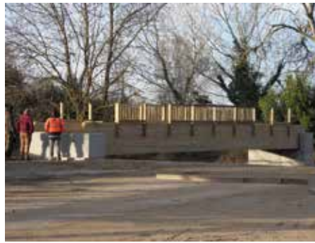
Installation de la passerelle à l'espace du Dardaillon
