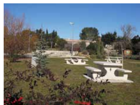
Installation de bancs à l'espace du Dardaillon
