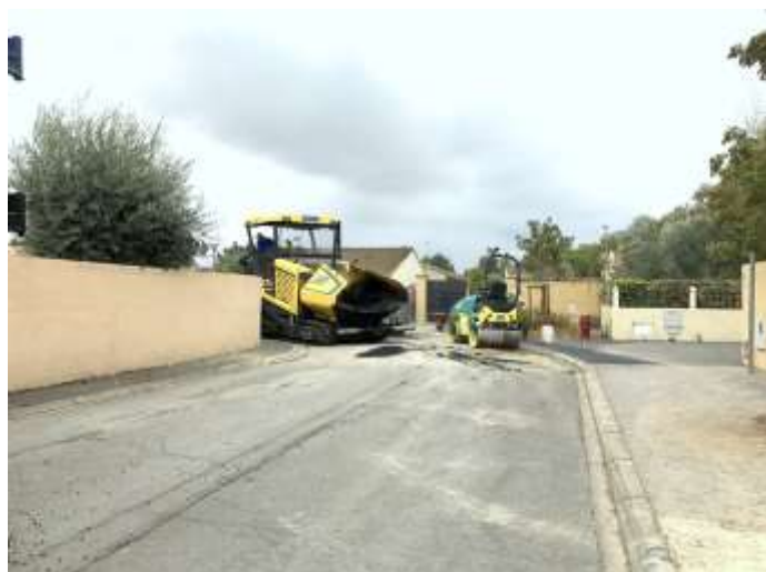
Réfection du lotissement de l'Abrivado
