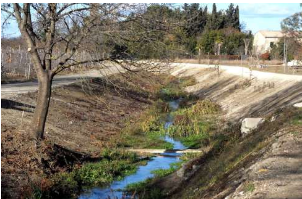
Nettoyage des berges et création d'un chemin de promenade (espace de loisirs du Dardaillon)
