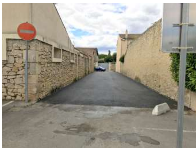
Réfection chemin des Primevères
